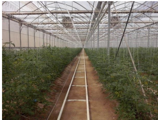
Figura 2: Ejemplo de estructura de uno de los invernaderos de BioSabor SAT
